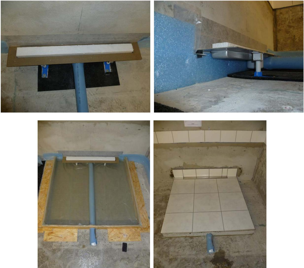
**Bild 3** Oben links: Gummigranulatmatte "Schallschutzelement" auf der Rohdecke unterhalb der Rinne und des Ablaufkörpers durchgehend verlegt (höhenverstellbare Montagefüße ausgespart). Rinne mit zwei Montagefüßen mit Elastomerendkappen und Kunststoffflaschen auf der Rohdecke verschraubt.
